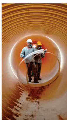
Fase 3: Instalação da luva *Iniciar posicionamento da luva.
